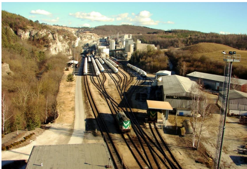
Celkový pohled na stanici Čertovy schody.
